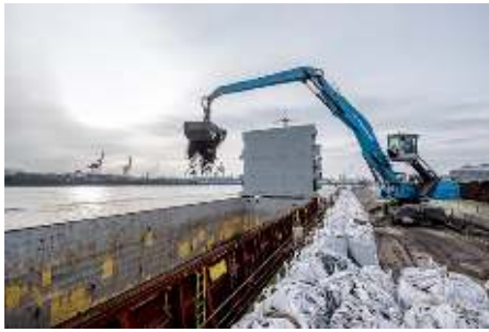
Transportweg Elbe: Rund 3.300 LKW-Ladungen Erde werden über den Wasserweg abtransportiert
